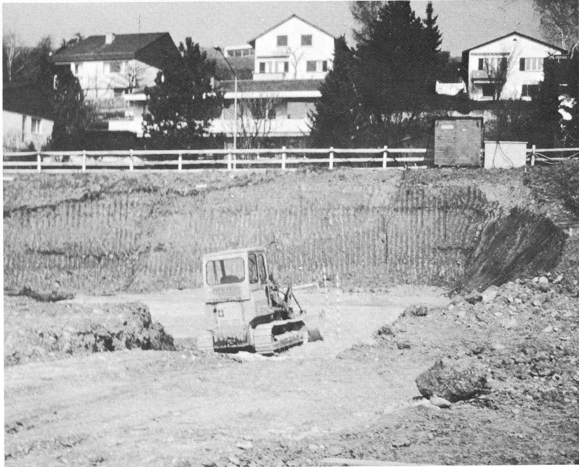
Abb.10 Östlicher Teil der Baugrube Bodenacher unmittelbar vor Baubeginn. Ansicht von Süden. Die Fundstellen «Bodenacher Ost» sind auf der Höhe des Traxdaches als dunkle Partien erkennbar (Pfeile). Der obere dunkle Horizont in der Grubenwand kennzeichnet die ursprüngliche Terrainoberfläche vor dem Bau der Sandackerstrasse. Aufnahme vom Verfasser.
