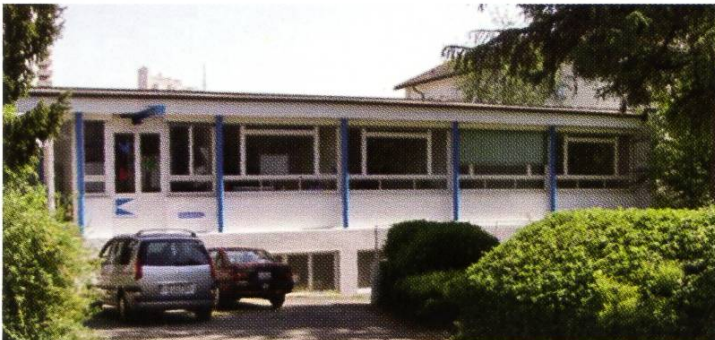
Neubau an der Adlikerstrasse 46 in Regensdorf
