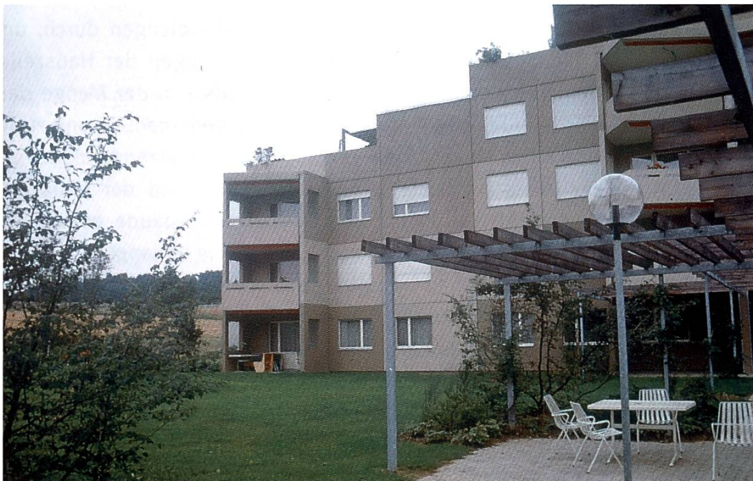
Die gestaffelten Hauszeilen enden auf beiden Seiten mit drei Geschossen (Photo Peter Steiger)
