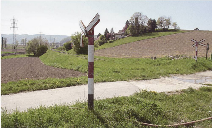
Der letzte unbewachte Bahnübergang im Furttal: Zusammenführung der Nordostbahn mit dem Nationalbahntrasse bei Otelfingen, 2014
