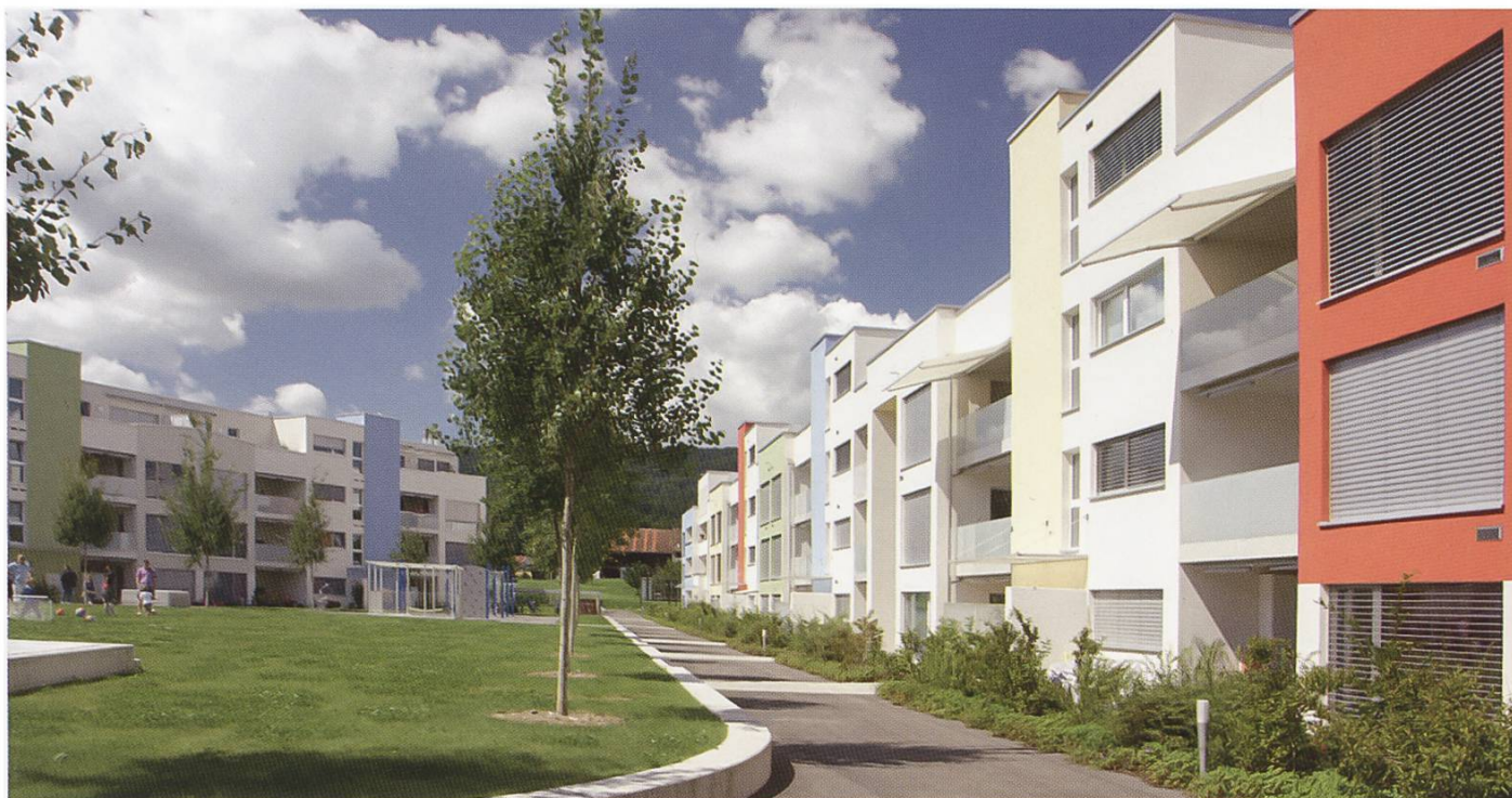
Wohnüberbauung «Im Park» beim Bahnhof Otelfingen, 2012
