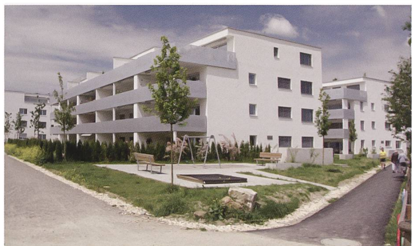
Die neueste Überbauung Chilenwiesenstrasse, 2015
