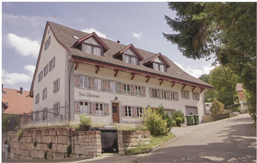
Der restaurierte Mühlehof an der Mühlestrasse, 2015
