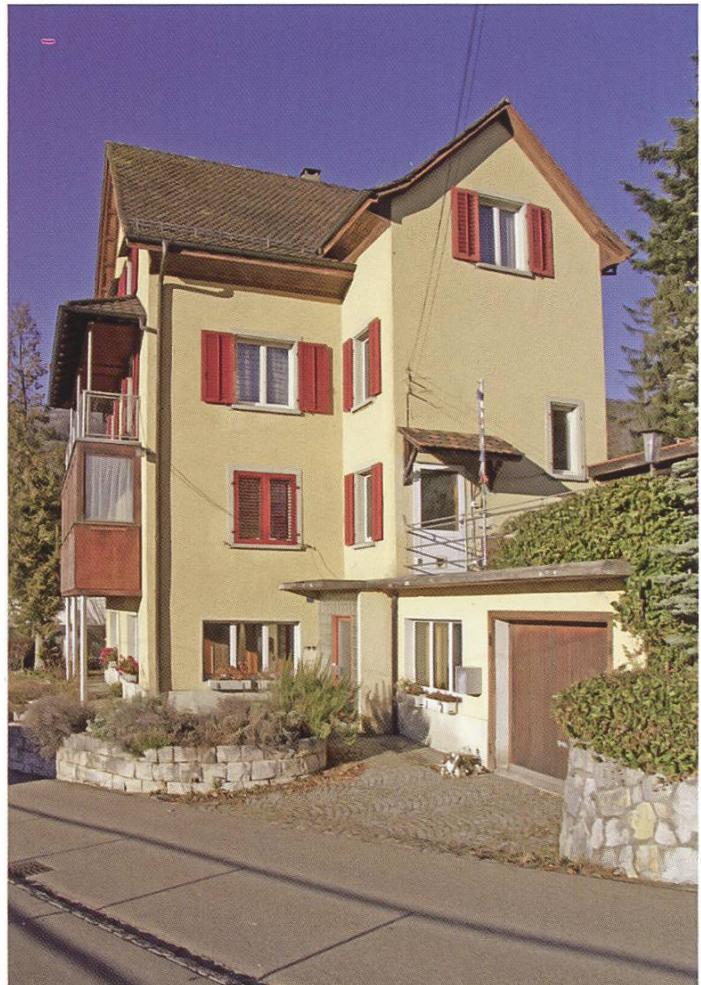
Das ehemalige Altersheim an der Sonnhaldenstrasse in Boppelsen
