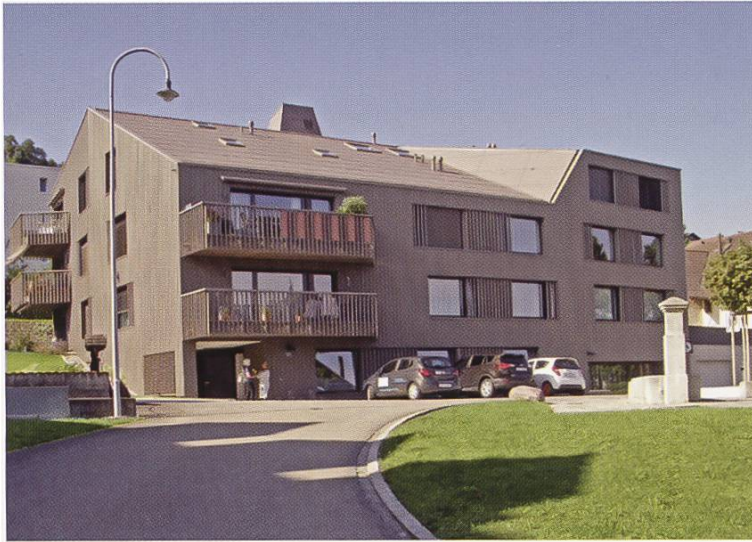
Alterswohnungen «Sagi» am Mühleweg in Regensdorf
