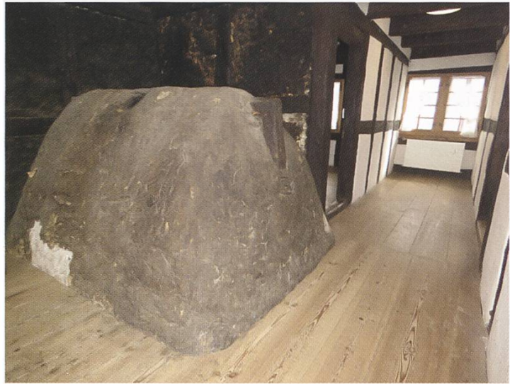
Abbildung 19: Chämihütte im oberen Stockwerk (Foto: Sabine Moser-Schliier)
