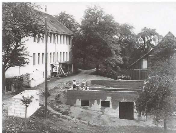
Abbildung 53: Bau des Magazins gegenüber der Fabrik an der Chriesbaumstrasse (damals noch ein Kiesweg) (Quelle: Peter und Lisbeth Güller, Hüttikon)
