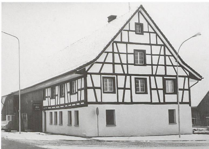
Abbildung 125: Der wieder sichtbare Riegelbau nach dem Umbau 1972 (Quelle: Heinz Berger, Hüttikon)
