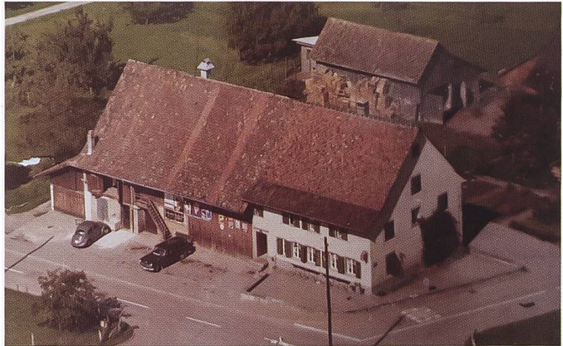
Abbildung 122: Aussenansicht des Restaurants vor der Renovation (Quelle: Heinz Berger, Hüttikon)
