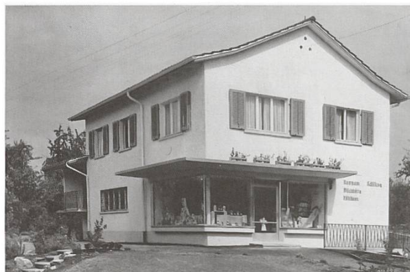
6 Filiale Adlikon mit Milchsammelstelle und Gemeinschaftstiefkühlanlage
