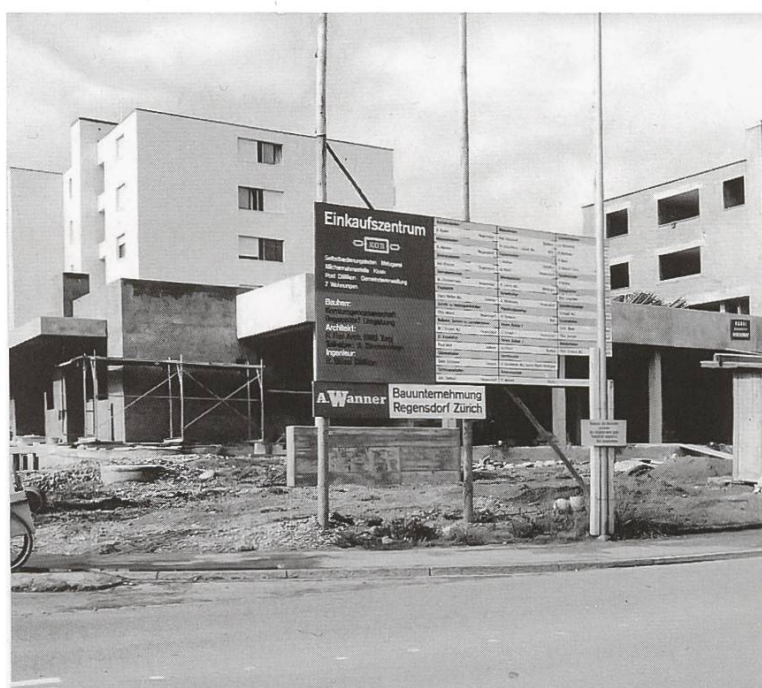
4 Bau des Selbstbedienungsladens mit Metzgerei und Kiosk 1967
