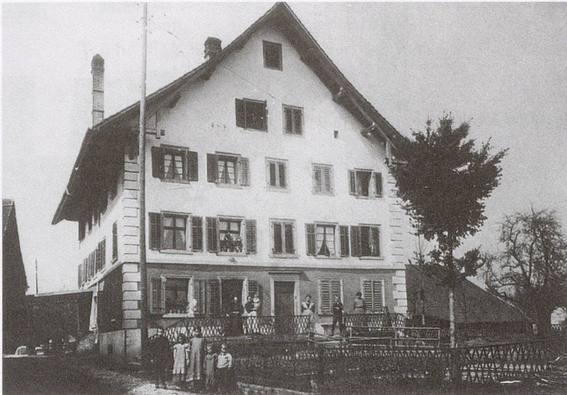
Abb. 4: Schmiedengebäude nach dem Umbau von 1920 (PA Weber). Der eingezäunte Garten vor dem Haus, durchschnitten von einem gemeinsamen Weg (ca. 250 m 2 ), war in sechs Parzellen aufgeteilt, wovon jede Partei zwei, nicht nebeneinander liegende besass.
