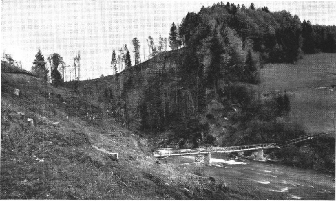
Abb. 1. Durchbruch der Sihl in den Schlagen nach abwärts gesehen. Stelle der Staumauer. phot. W. Marthaler, V. 1934
