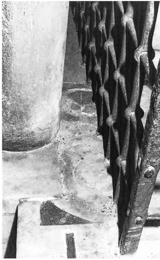
Abb. 23: Rom, S. Lorenzo f.l.m., Confessio: Auflage der Säule auf der Deckplatte. Das Muster wird durch die Säule teilweise verdeckt.
