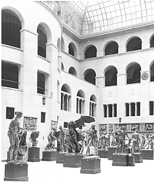
Abb. 14: Universität Zürich, Hauptgebäude: Blick in den Lichthof (1914).
