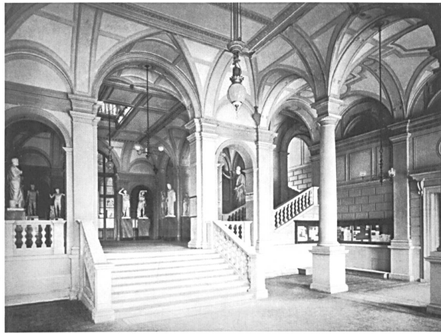
Abb. 10: ETH Zürich, Hauptgebäude: westliche Eingangshalle und Aufgang zur Antikenhalle, Zustand Ende des 19. Jahrhunderts.
