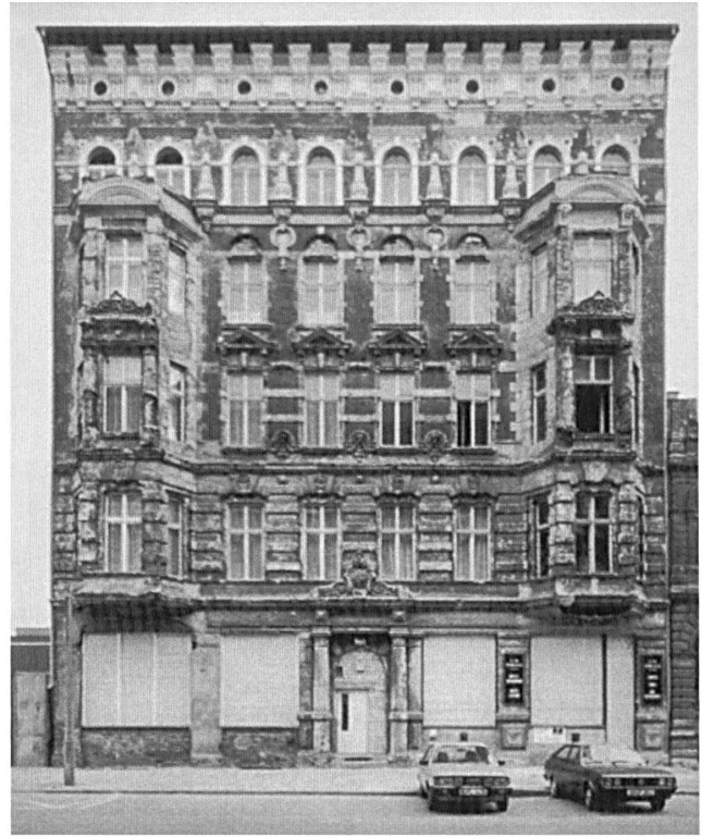
Abb. 4: Berlin, Ansicht des erhaltenen Altbaus in der Schützenstrasse vor Beginn der Bauarbeiten.
