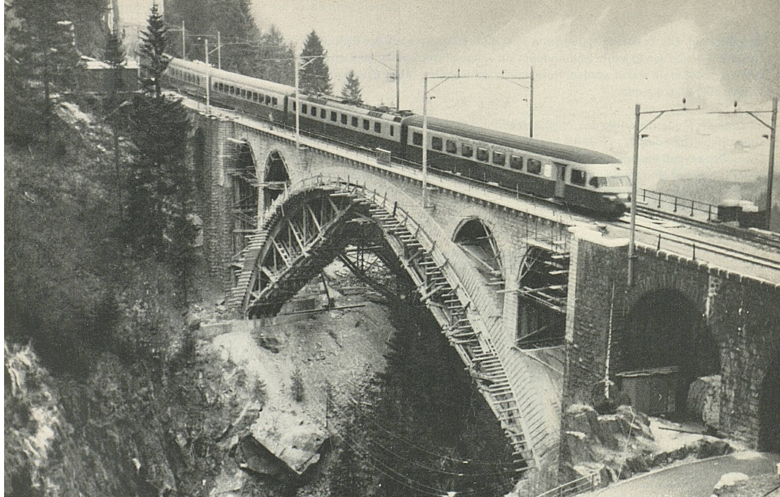
Der neue elektrische Trans-Europ-Expresszug auf seiner Fahrt über die im Umbau befindliche mittlere Meienreussbrücke auf der Gotthardlinie
