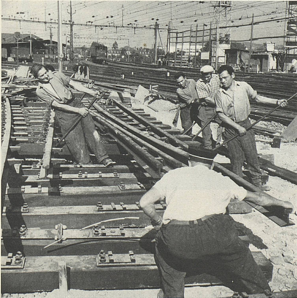
Auch beim Einbau der Weichen bedarf es der menschlichen Arbeitskraft
