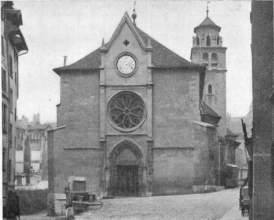
FIG. 2. — La façade occidentale avant la restauration.
