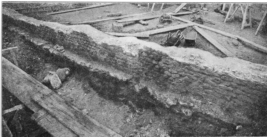
FIG. 10. — Vue du mur méridional de l'édifice romain.
