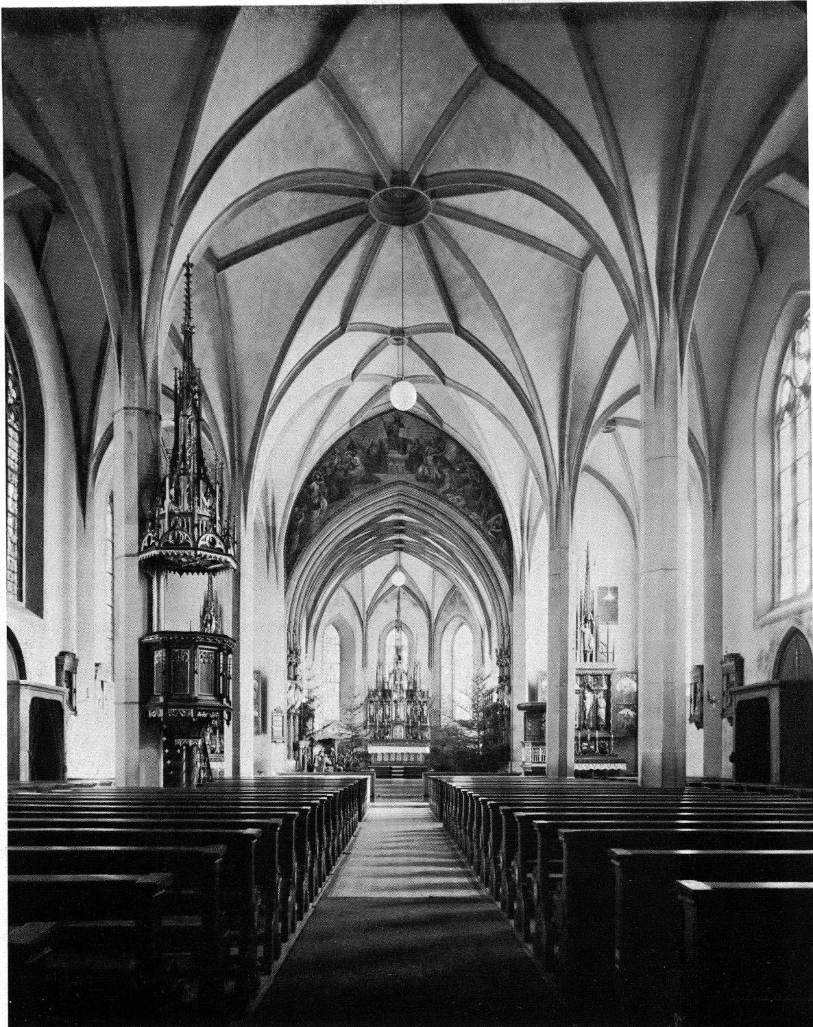
Abb. 15. Wil. St. Peterkirche von August Hardegger, vor dem Umbaus (Chor spätgotisch).
