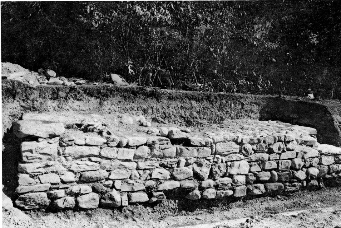
Fig. 10. Hermance. Fondation de la tour, vue en direction sud-est.
