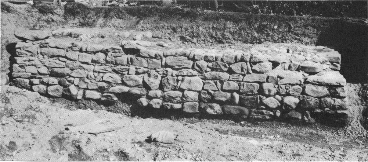
Figure 6. La tour carrée, côté ouest.
