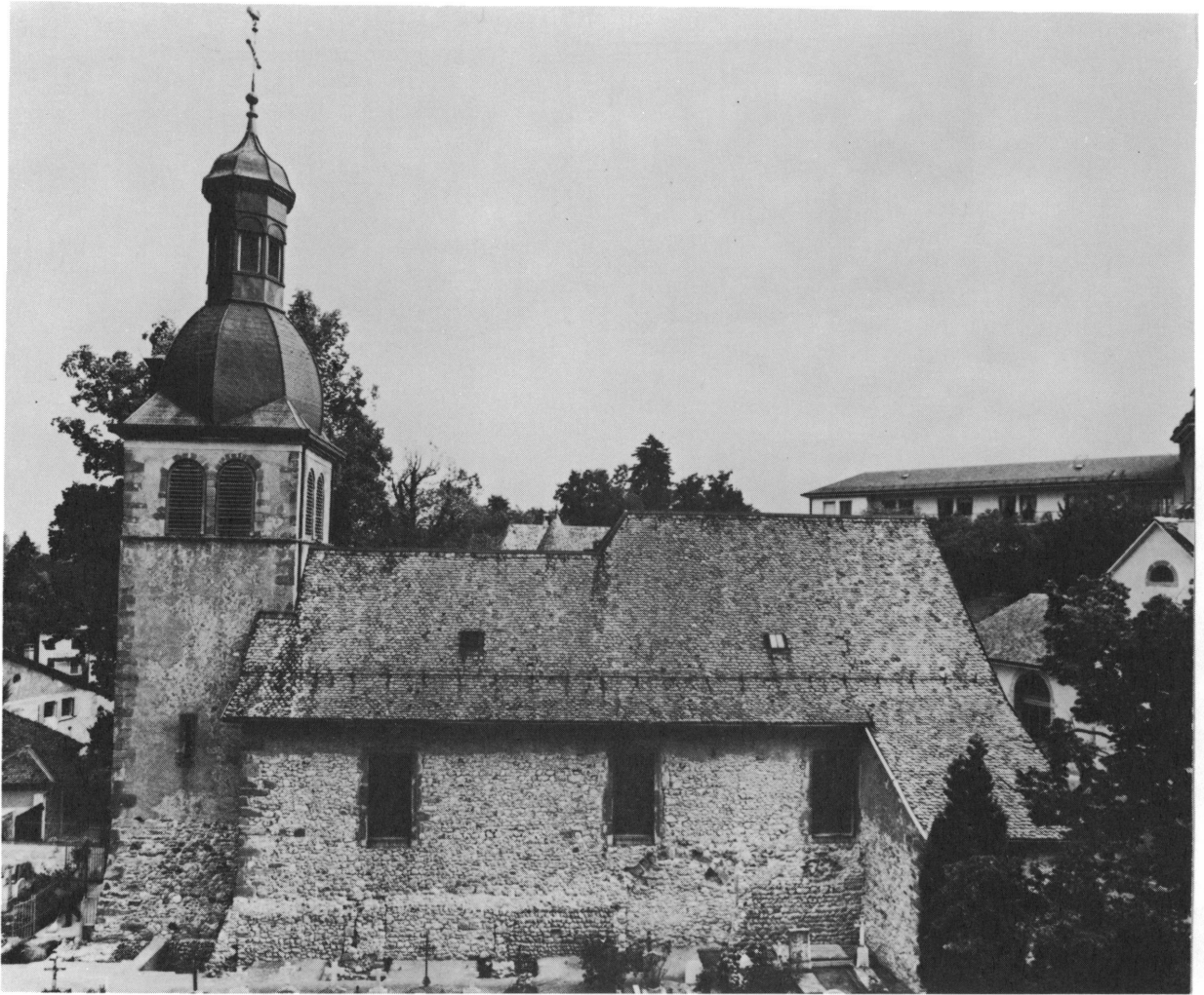
Figure 44. Mur latéral sud de l'église.
