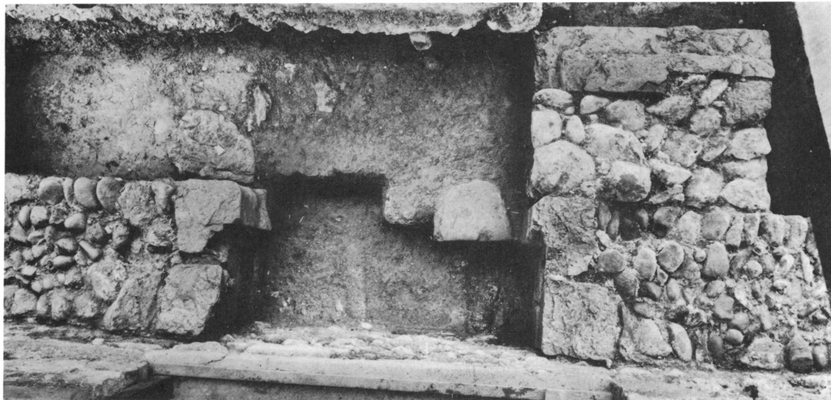
Figure 26. Porte d'entrée de l'église du XIII e siècle.
