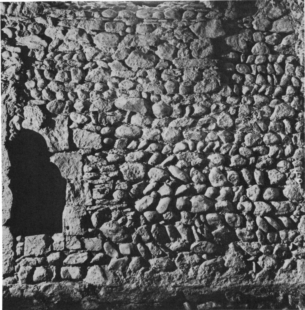
Figure 24. Paroi intérieure sud du chœur, première travée.
