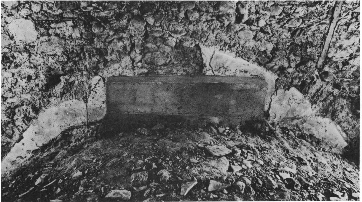
Figure 23. Chœur du XIII e siècle. Traces de la voûte au-dessus des voûtes actuelles.
