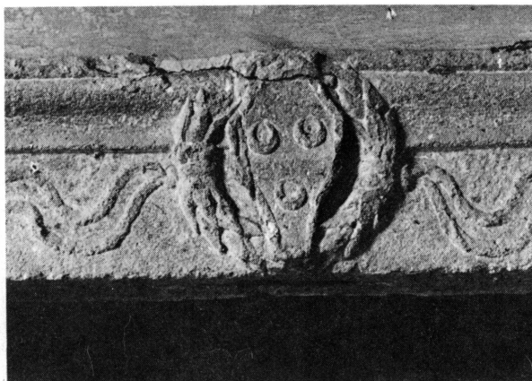
Fig. 7. La Crescenza. Détail d'un linteau.
