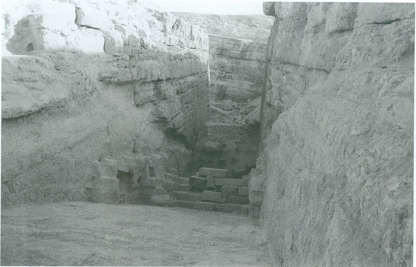
9. La descenderie au terme des travaux de la saison.
