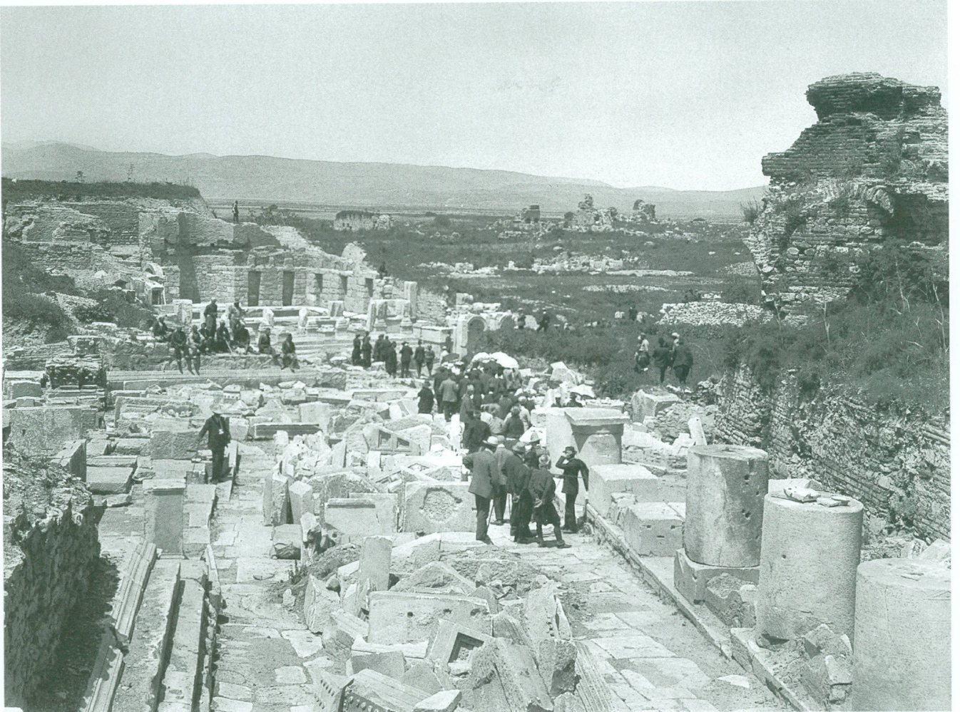
9. W. Deonna, Ephèse, bibliothèque de Celse et rue des Courètes , avril 1905. Depuis le haut de la rue, au centre de laquelle sont entassés pêle-mêle les fragments architecturaux des bâtiments qui la bordaient, apparaît l'un des bâtiments les plus célèbres de l'ancienne Ephèse : la bibliothèque de Celse, dont seules les quelque premières assises sont encore visibles. Dans le fond, au pied des vestiges monumentaux d'un aqueduc, le site antique n'est pas encore dégagé. Genève, Musée d'art et d'histoire, fonds Deonna, Inv. 1459
