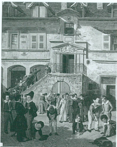
10. Inconnu | La Cour du Collège , vers 1842 | Huile sur toile (collection privée) | Au rez-de-chaussée, à gauche, les ouvertures ont déjà été agrandies ; à droite, elles attendent de l'être. À l'étage, on peut voir la maçonnerie brique et pierre.
