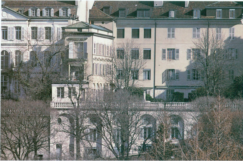
1. Rue des Granges 10 : la galerie vue du toit d'Uni-Bastions
