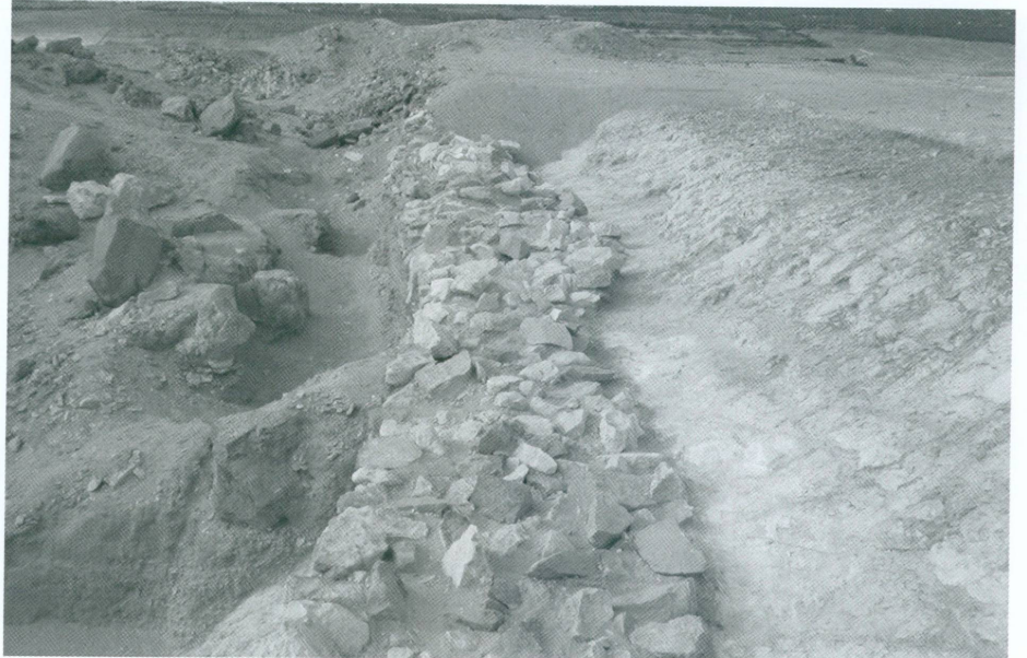
(fig. 4). L'ensemble de cette enceinte, y compris ses portes, a fait l'objet de restaurations sur une hauteur moyenne d'un mètre.
