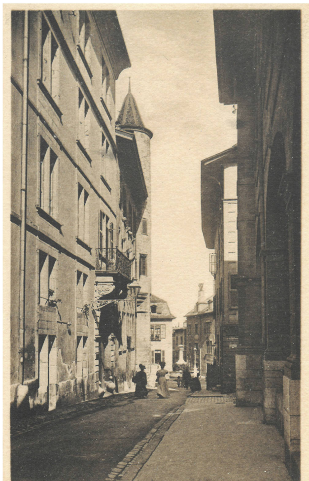
La Rue du Puits de St. Pierre et Maison Tavel - Genève
