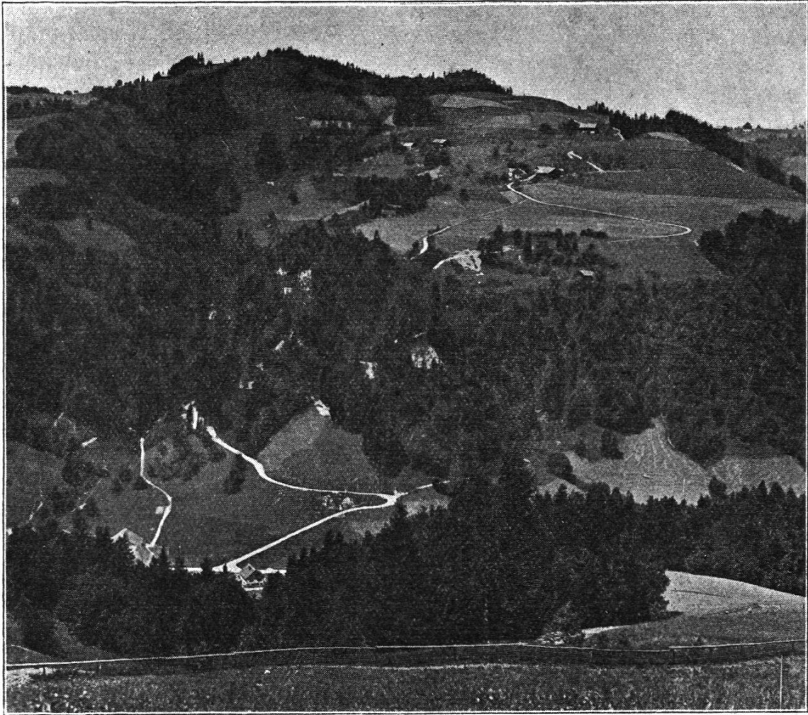
Ansicht der Flurweganlage Mühlebach-Reinsberg. Photo von der gegenüberliegenden Talseite aus.
