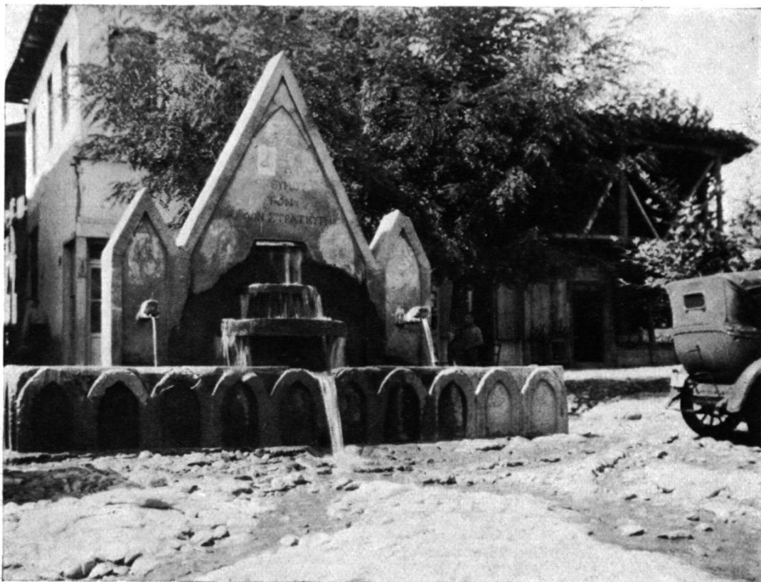
Figur 4. Ueberlaufbrunnen der Wasserversorgung von Gümendji, von der französischen Orientarmee erstellt.
