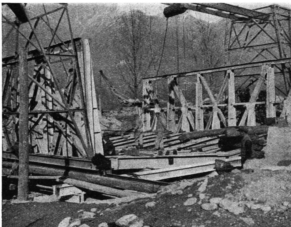
Abb. 5. Stahlkonstruktion der Kanalbrücke.
