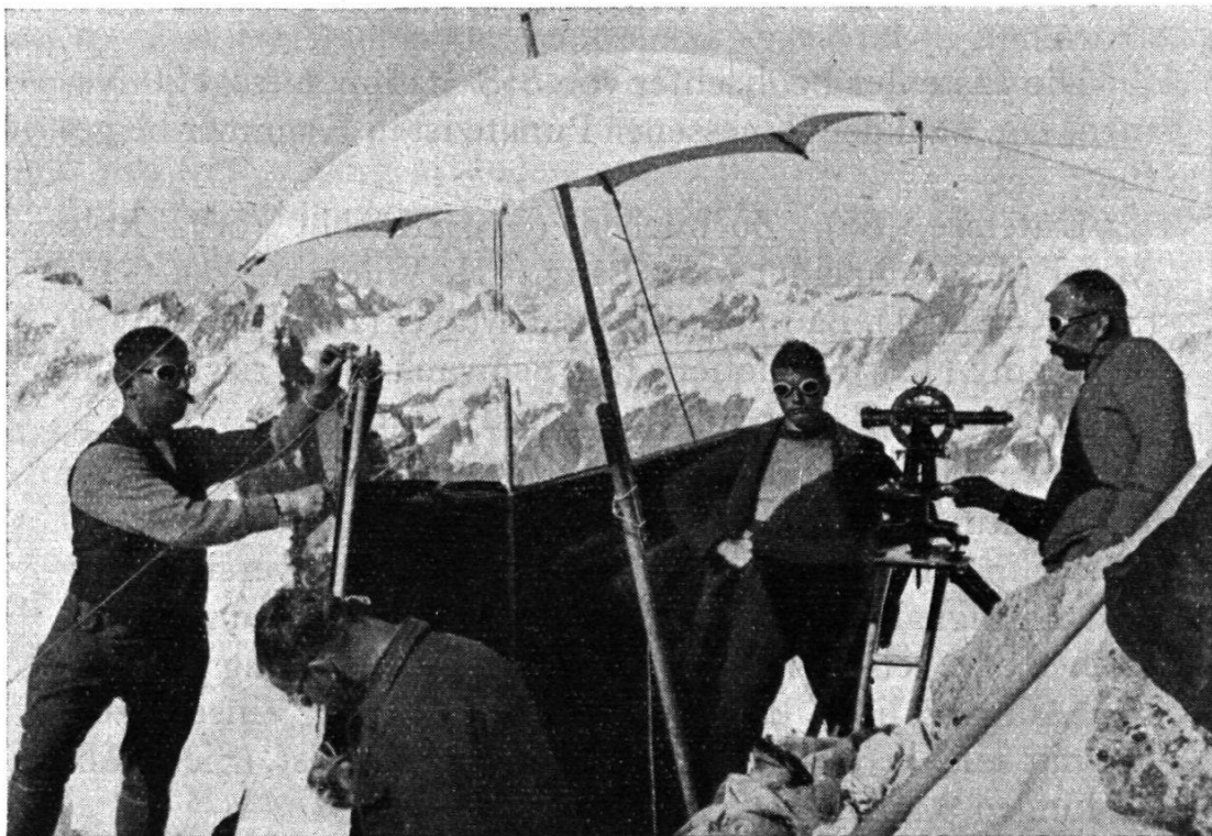
Abb. 10. Winkelmessung auf Cima della Bondasca durch Ing. H. Dübi und Ing. H. Zölly
