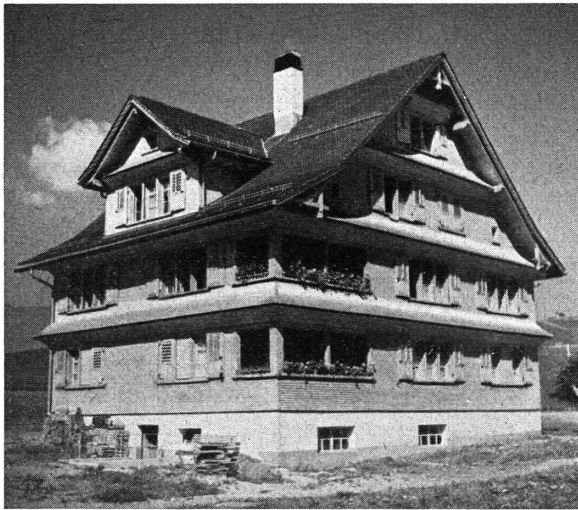
Neues Zweifamilienhaus im Dorfkern.
