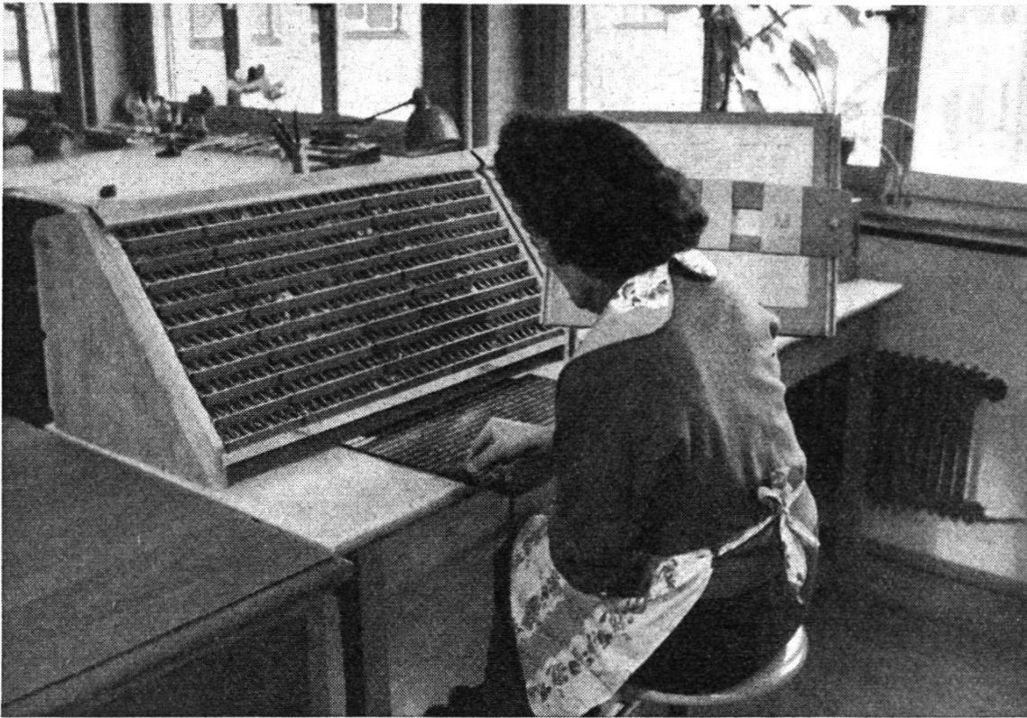
Abb. 6. Das Schriftsetzen mit dem neuen Schriftsatz
