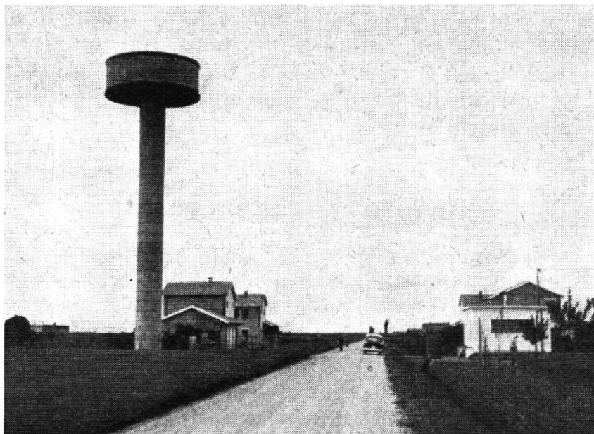
Pumpenhaus und Wasserturm bei Magazzeno
