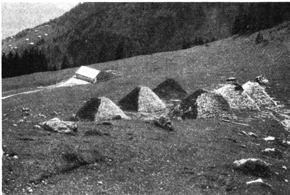
Die sechs Lawinen-Bremshöcker auf der Alp Hinteraltschen, Amden SG. Sie sind teilweise humusiert. Im Hintergrund das neue Alpbäude mit dem Lawinenschutz
