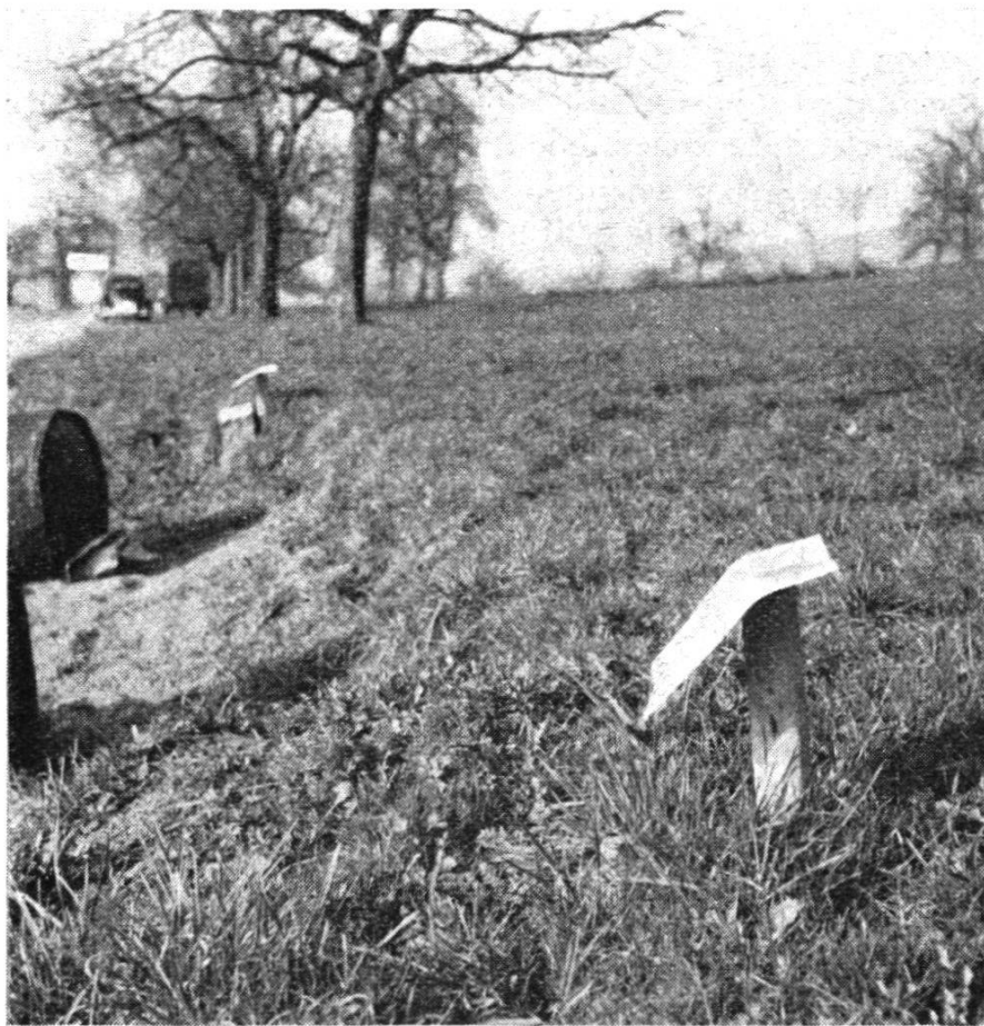
Abb. 2. Exzentrisch angebrachte Signaltafel, ungünstig
