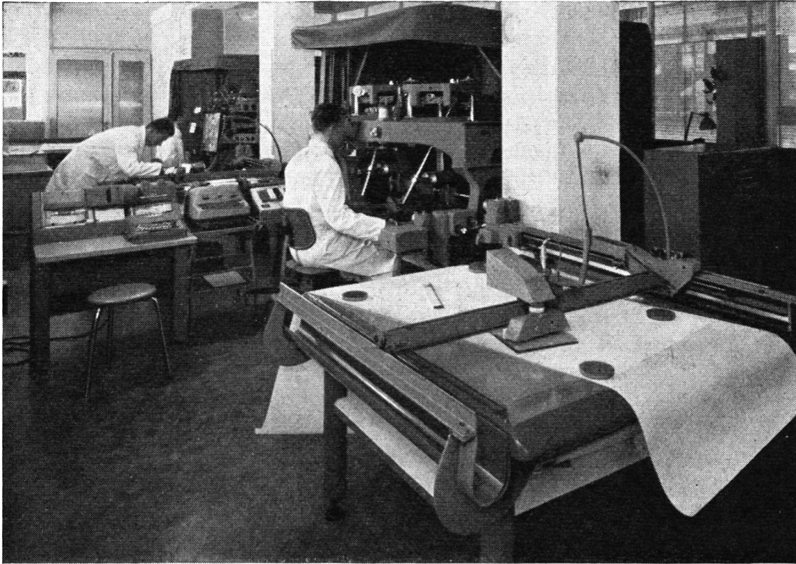
Abb. 2. Autograph Wild A 7 mit automatischer Datenregistrierung. Links vom Operateur Steuerpult, Schreibmaschine und Kartenlocher; rechts vom Zeichentisch der Relaisschrank
