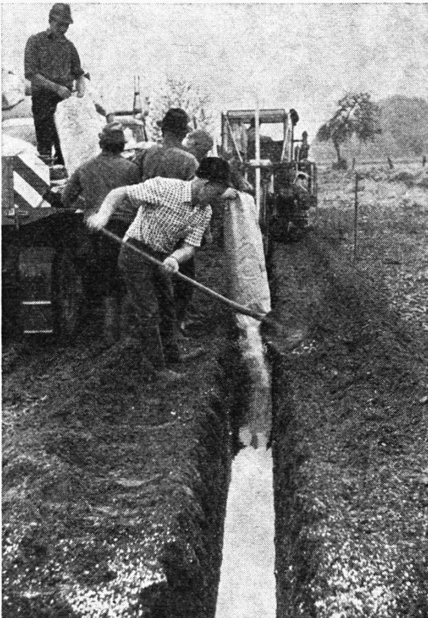
*Bild 6:* Zur Sicherung eines extrem hohen Wasserabflusses wurden die PVC-Dränrohre eines Abwasser-Rieselfeldes mit einer besonders dicken Styromull- Filterschicht bepackt
