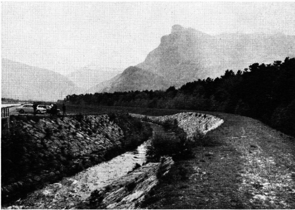
Der Saarablenkanal unmittelbar vor seiner Einmündung in den Rhein (erbaut 1956–61, Aufnahme Mai 1971). Die Natur sorgte von selbst für die «Tarnung» der Pflasterung. Im Hintergrund der Gonzen.
