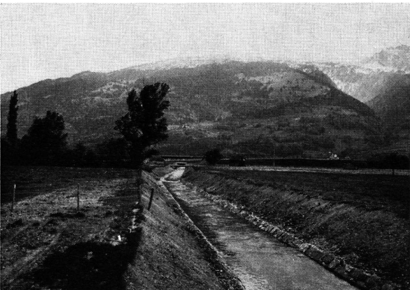
Der neuausgebaute Saarkanal im Frühjahr 1971, unmittelbar unterhalb der Kreuzung mit der Autobahn, unter Schonung des alten Baumbestandes.
