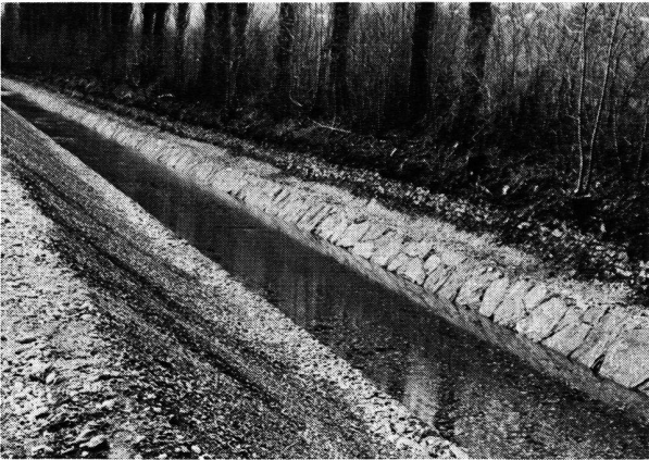
Der korrigierte Saarkanal. Dank einseitiger Verbreiterung und trotz Vertiefung konnte der Pappelbestand am linken Ufer erhalten bleiben. Man beachte die neue Uferpflasterung und die natürliche Kiessohle. Deutlich erkennt man noch die alte, vor mehr als 100 Jahren erstellte Pflasterung mit kleinen Steinen am Fuße der Bäume und Sträucher. Sie wird bald überwachsen und nicht mehr sichtbar sein. Zustand Frühjahr 1971.
