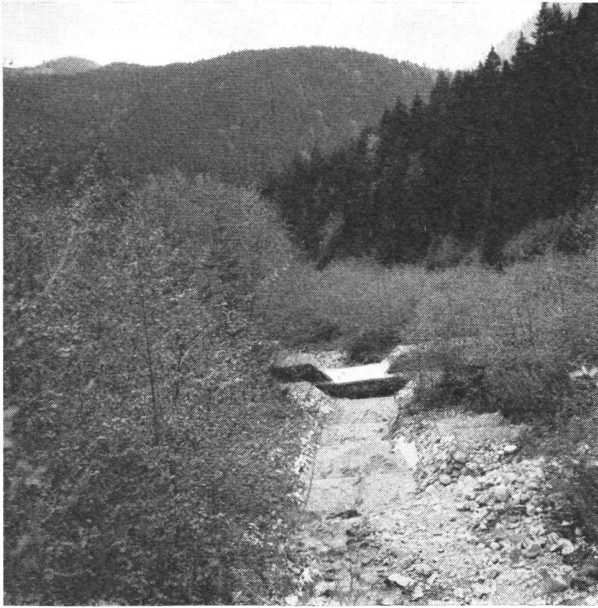
Abb. 3 Mit Querwerken, gepflasteter Bachsohle und Grünverbau wird ein Zufluß des Halblechs saniert. Die Geländerutschungen sind bereits vermindert worden.
