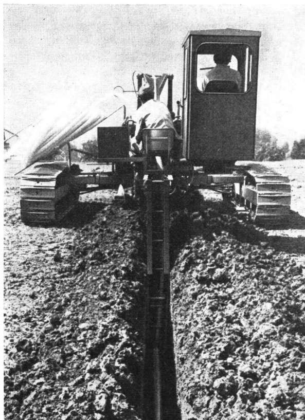
Abb. 3 «GFP 3», Verlegung von KD-Flex (Werkphoto).
