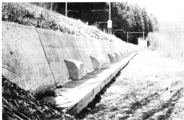
Figure 1 Le mur de soutènement avec les têtes d'ancrage
