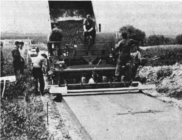
Fig. 6 Construction d'une chaussée agricole en béton
