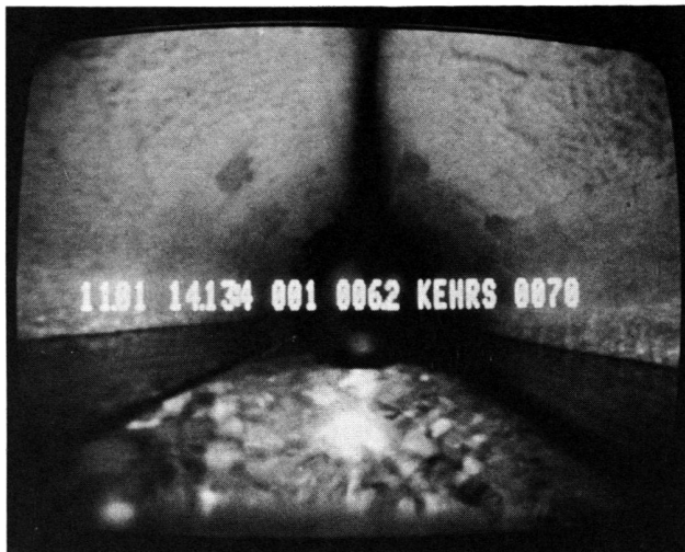
Abb. 2 Kiesablagerung in der Rohrsohle. Die eingeblendeten Ziffern bedeuten von links nach rechts: Datum, Zeit, Aufnahme-nummer, Entfernungsangabe, Ort, Rohrdurchmesser.
