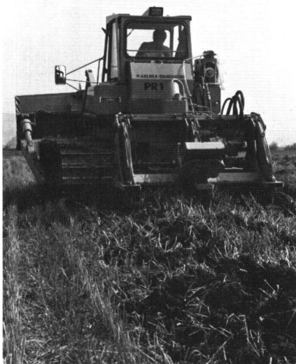
Abb. 1 Tieflockerungsmaschine, mit der die Versuchsfelder gelockert werden
