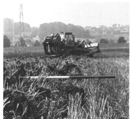
Abb. 7 Primärauflockerung ergibt eine Zunahme des Porenvolumens von 20–30%
